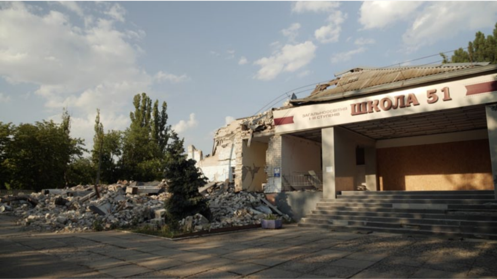
Зруйнована Росією 51-ша школа в Миколаєві
