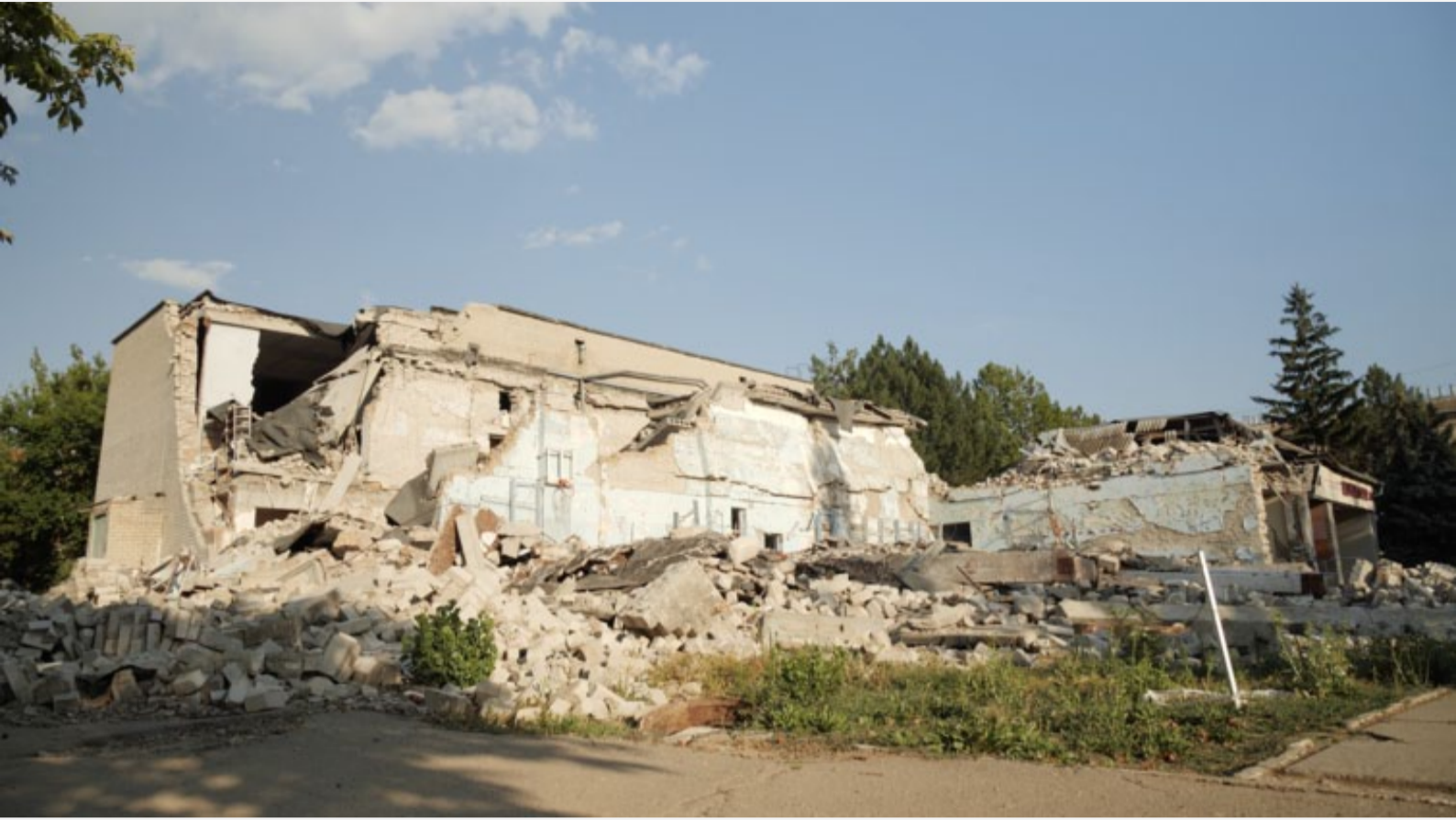
Зруйнована Росією 51-ша школа в Миколаєві
